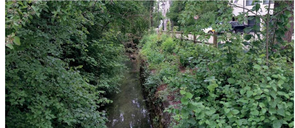
Abbildung 11: Pfförring, Kelsbach im Bereich Ungergarten Foto: D I S
