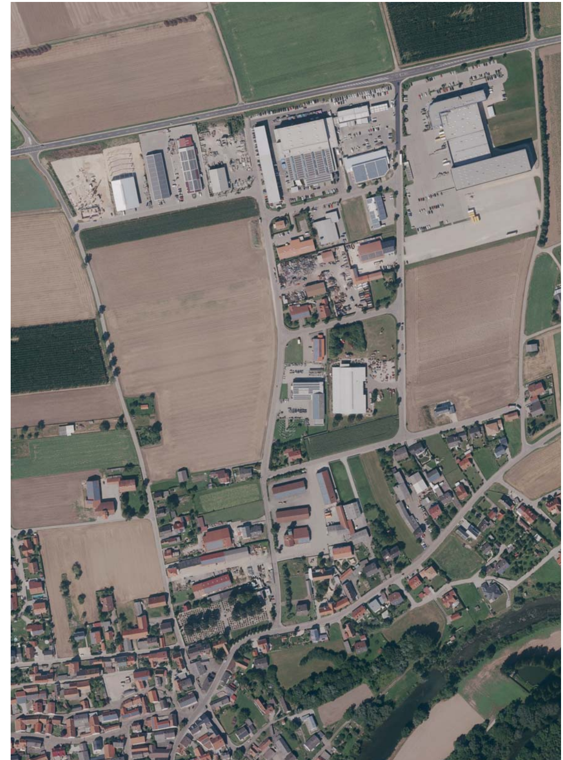
Abbildung 129 Orthophoto - Gewerbegebiet Pförring Quelle: Bayerisches Landesamt für Digitalisierung, Breitband und Vermessung
